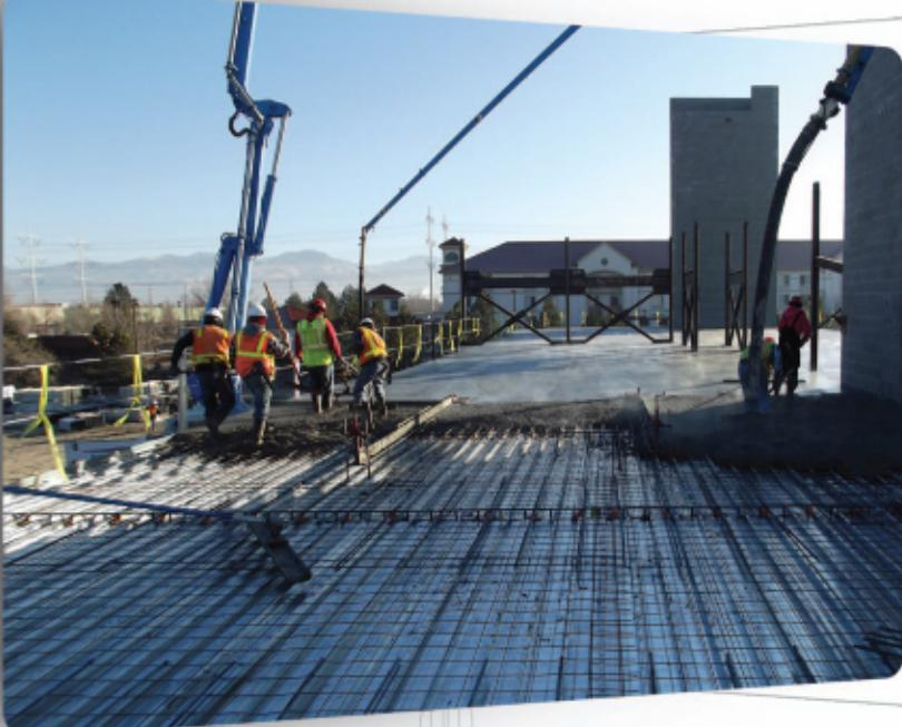
سقف آماده بتن ریزی میگردد. سپس بتن ریزی روی سقفهای آماده صورت گرفته و روی سقف پخش میشود باید توجه داشت ضخامت بتن از روی بالاترین سطح ورق نباید کمتر از ۵ میلیمتر باشد
